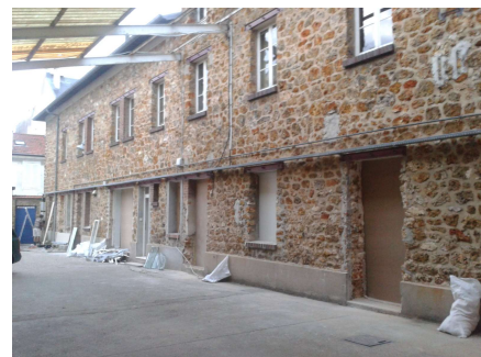
Cour de récréation et locaux du primaire, 34 rue Rémilly avant travaux en 2014
